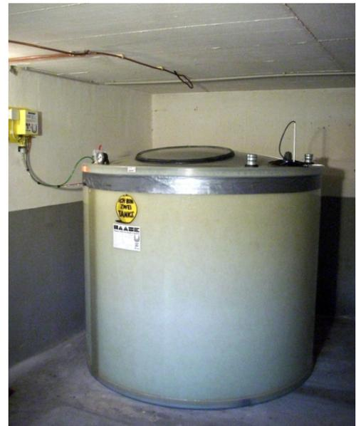
Der fertig montierte Haase-Kompakt-Tank
